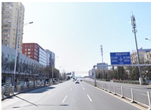
图 2-11 现状广安路（西三环-太平桥路）
