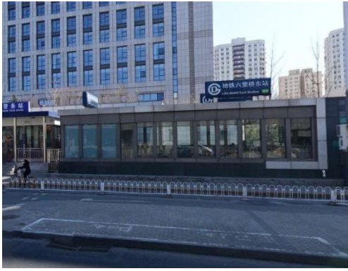
图 2-20 现状六里桥东站
